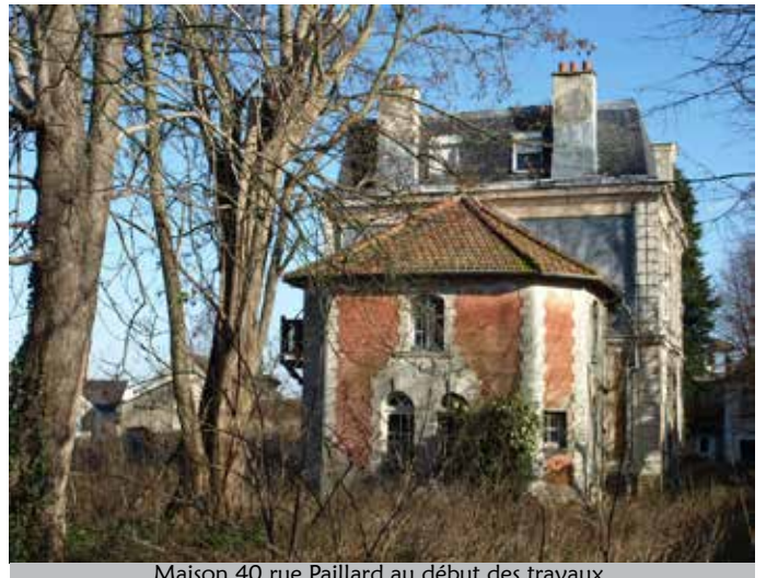
Maison 40 rue Paillard au début des travaux.
