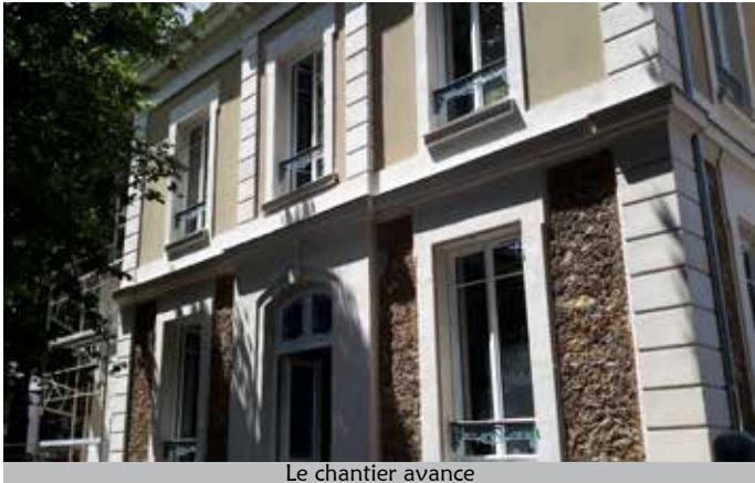
Le chantier avance
