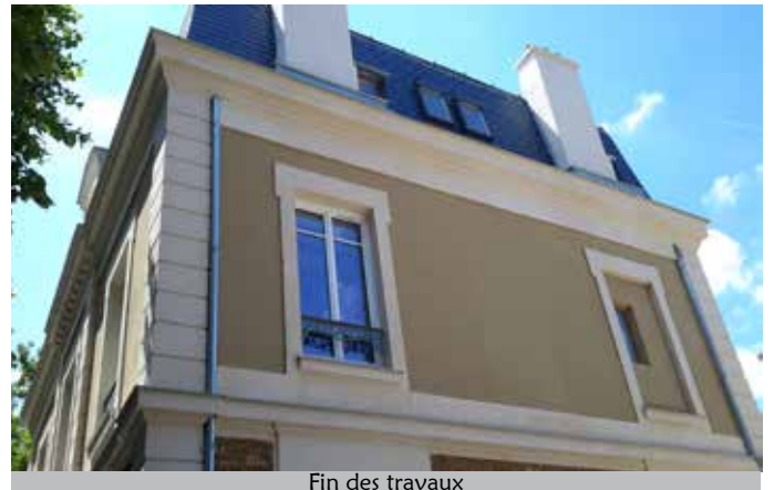
Fin des travaux
