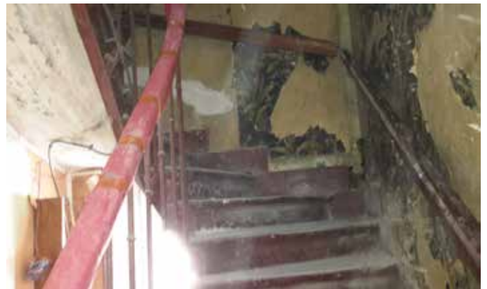
Avant les travaux.
